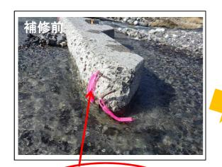
床固工の魚道部で 摩耗により鉄筋が露出
