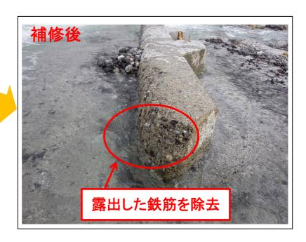
露出した鉄筋の除去により、川の中での安全性が向上。
