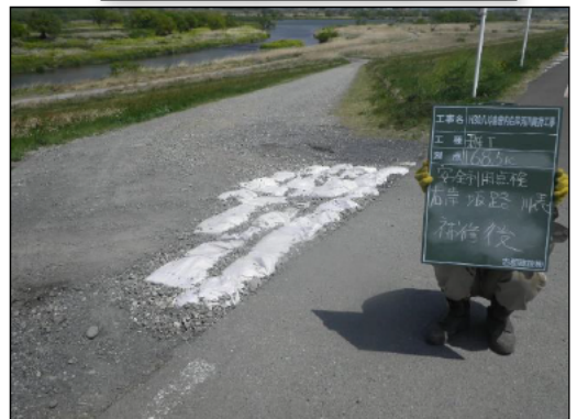
土のう設置により段差の解消
