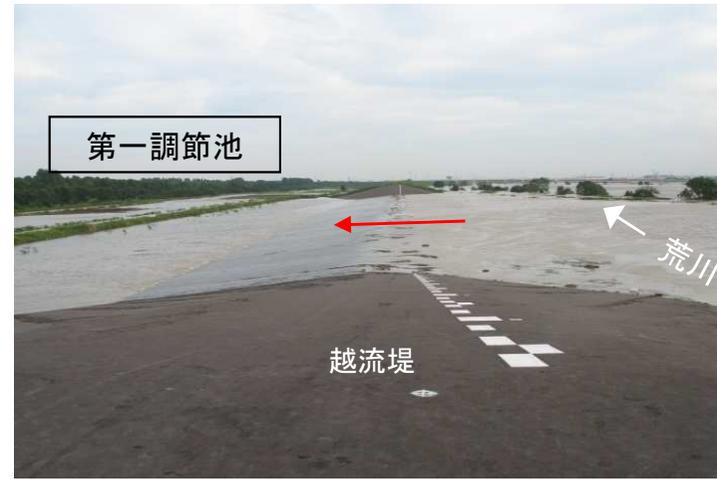
平成19年9月 越流堤部の洪水流入状況
