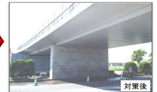
今回の工事は、杭の増設とロックンク橋脚をコンクリートで巻き込んで、壁化して強度を向上させる工事となります。
