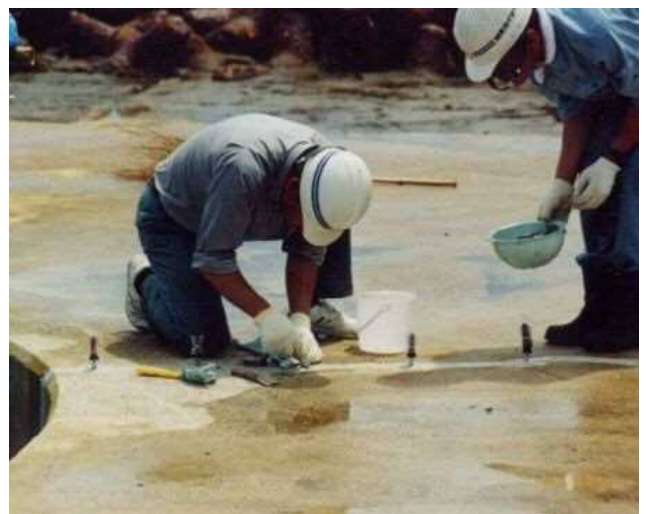
コンクリート護岸ひび割れ補修
