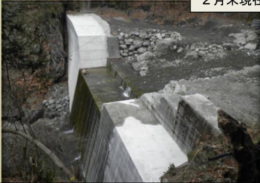
赤沢地先 砂防堰堤の改築を行っています
