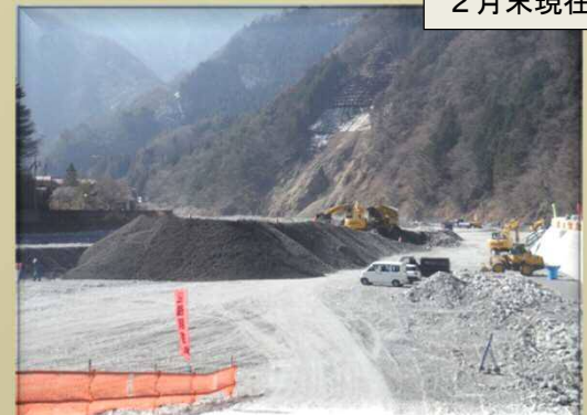
奈良田地先 工事用道路の整備を行っています
