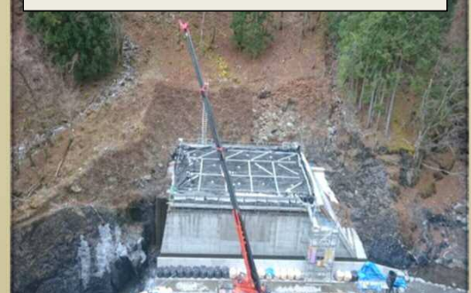
新倉地先 砂防堰堤の整備を行っています
