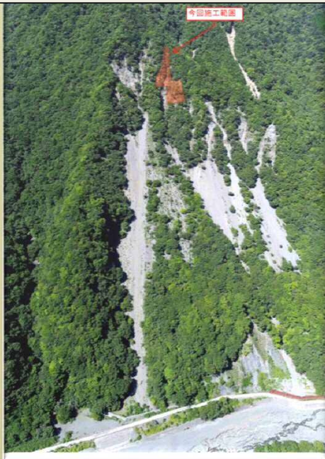
赤沢地先 土砂崩れの対策を行っています
