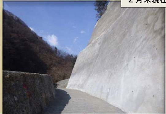
保地先 工事用道路の整備を行っています
