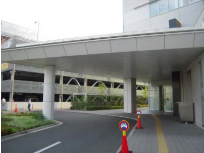
車が入る庇（車寄せ）
