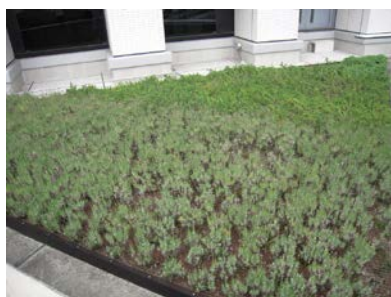
屋上緑化の設置
