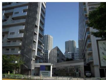
住宅地区(中心状況)
