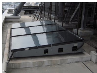
太陽熱給湯設備の設置
