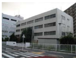
横須賀地方合同庁舎
