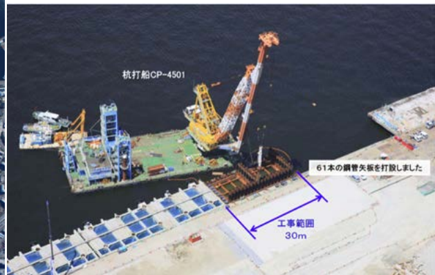
写真4 取付け部の施行状況
