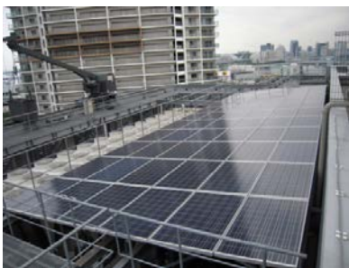
太陽光発電設備の設置
