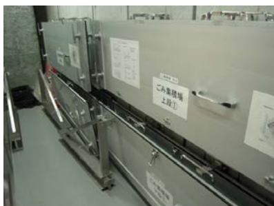
浸水対策として止水板の設置
