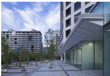
広場状空地(庁舎入口側)
