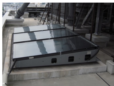
太陽熱給湯設備の設置
