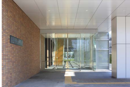
1F 自動扉出入口
