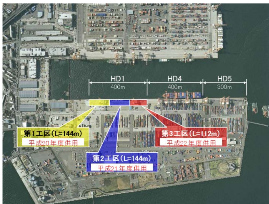
写真5 HD1岸壁改良工事の段階施工
