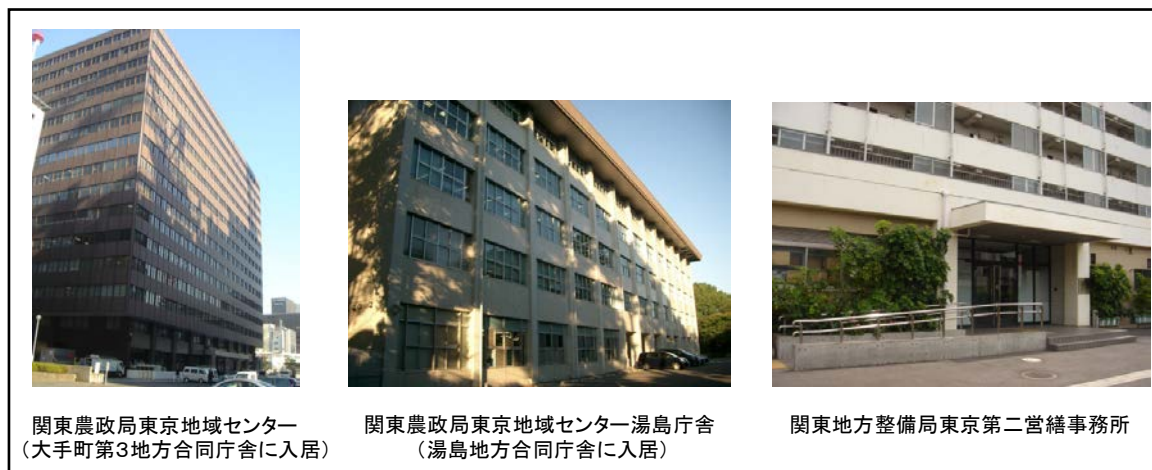
写真1 入居前の旧庁舎の状況
