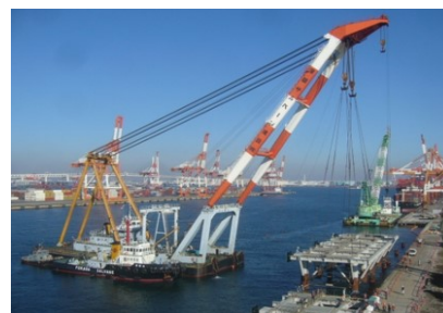
写真 6 ジャケット据付状況
