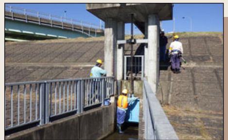
▲河川管理施設の点検状況
