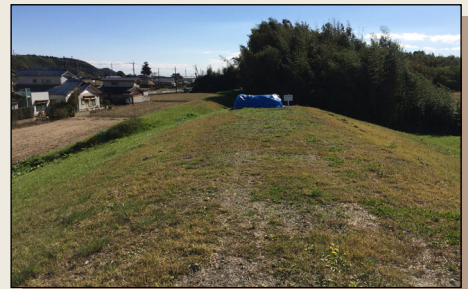
▲断面が不足している堤防
