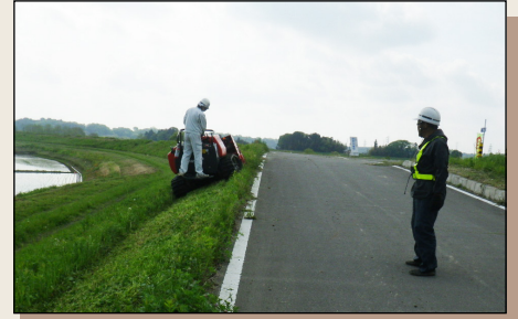
▲堤防除草作業の状況
