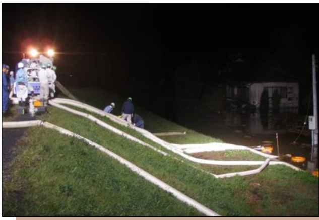
▲ポンプ車活動状況
