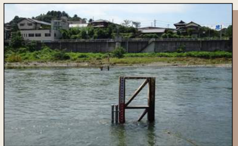
▲山方水位観測所
