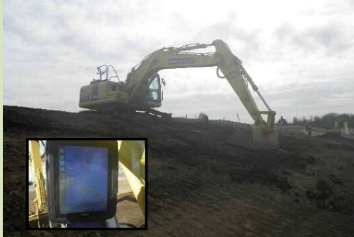
MCバックホウの法面整形
