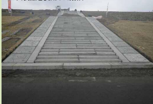
二次製品を使用した階段
