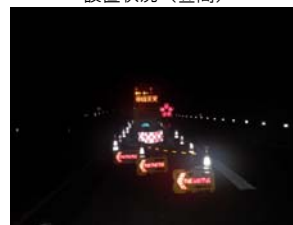
設置状況(夜間)
