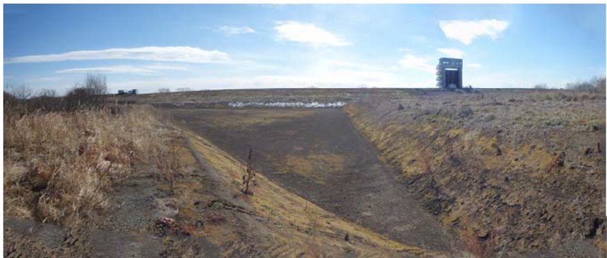
写真 3 掘削状況 (Y. P. +5. 5m) (撮影：平成 30 年 1 月 30 日)
