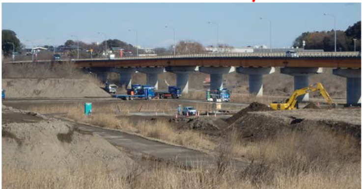
写真 2 仮置きヤード状況 (撮影：平成 30 年 1 月 30 日)
