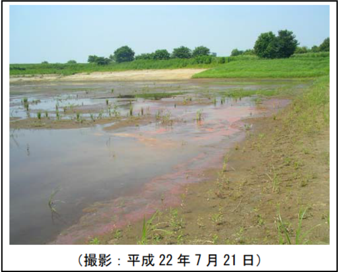
写真 5 第 1 試験地 (Y.P. +2.8m) 掘削直後の状況
