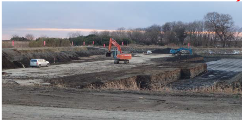
写真 1 掘削状況 (Y. P. +3. 4m) (撮影：平成 30 年 1 月 30 日)
