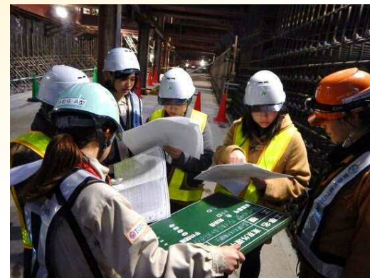
仕事体験（配筋検査）
