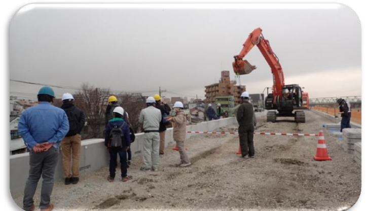
護岸ブロックの設置状況を見学
