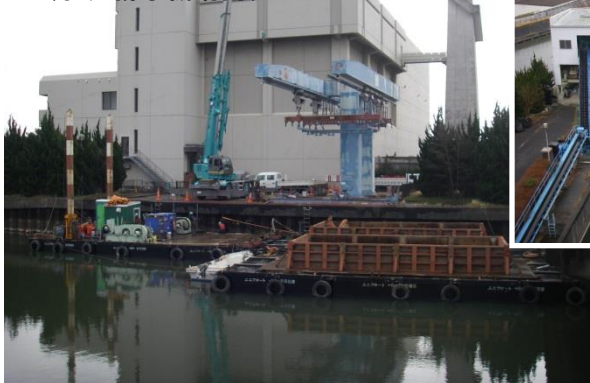
浚渫土を運搬する土運船の組立状況 （松戸排水機場内）
