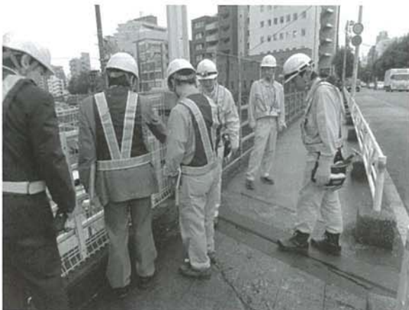
写真－4 地方公共団体との合同現地調査の状況
