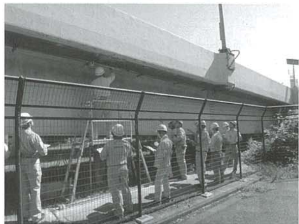
写真－5 研修の状況（上：講義，下：点検実習）
