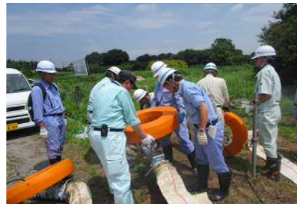
排水ポンプ設置訓練
