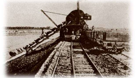
蒸気掘削機を使い水路を掘削
