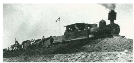
荒川改修工事 (現 埼玉県さいたま市馬宮付近)
