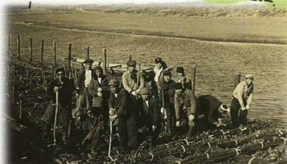
護岸根固工事の様子 (粗朶沈床設置作業)
