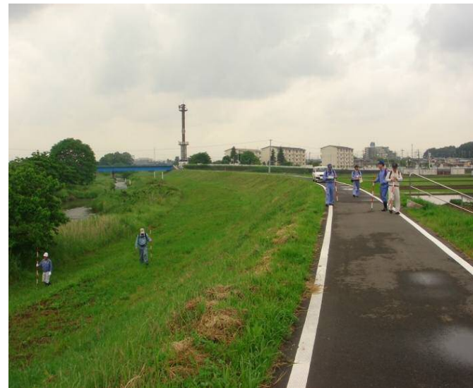
出水に備えた堤防点検の様子
