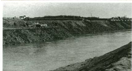
荒川改修工事 (現 埼玉県さいたま市馬宮付近)
