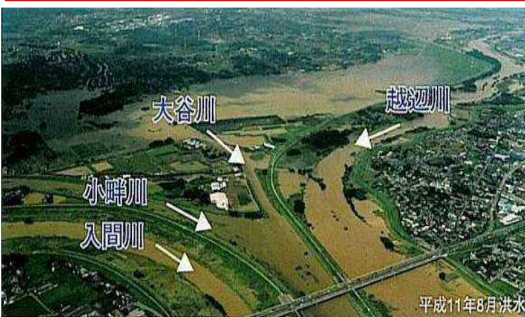
平成11年8月出水時の様子
