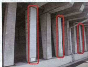
写真-1 シート接着技術 （赤枠の部分が施工箇所）
