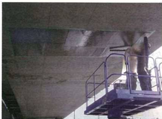
写真-10 試験施工状況 (国道16号太田山高架橋)
