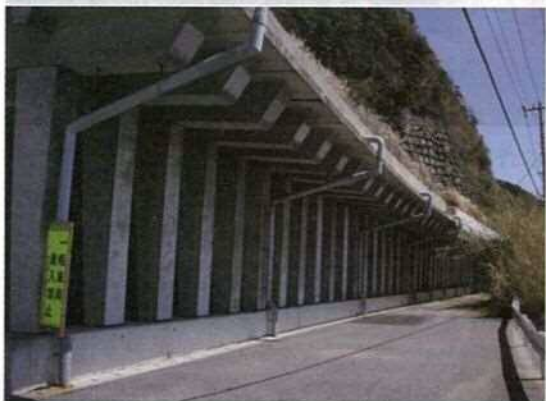
写真-11 試験施工構造物 (国道127号元名第一ロックシェッド)
