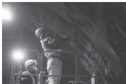
写真—3 A技術の施工状況
