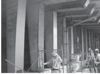
写真一6 ロックシェッドにおける試験施工
