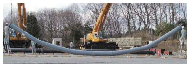
写真-5 硬質塩化ビニル管の継手要素試験
