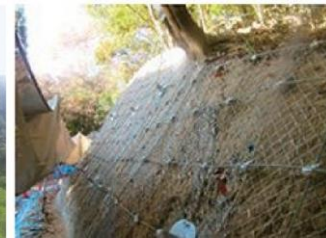
仮設法面工施工例
