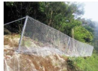
仮設落石防護柵施工例
