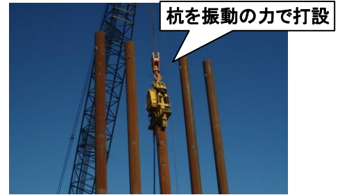
バイブロハンマ工法の施工例
