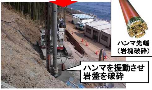
ダウンザホールハンマ工法の施工例
