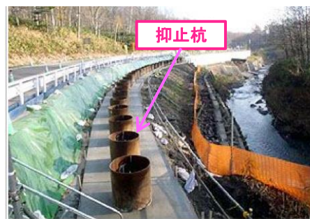
抑止杭施工例
