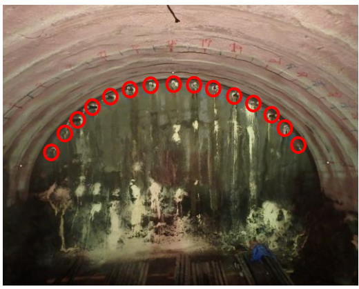
長尺鋼管先受工施工例 ○:長尺鋼管先受工
