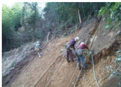
従来工法(人力土工)
