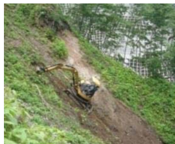
無人化施工機械による土工
