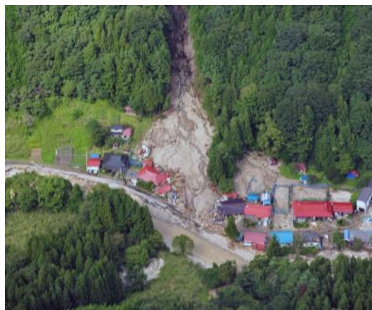
芹沢集落(滝向沢)の被災状況
