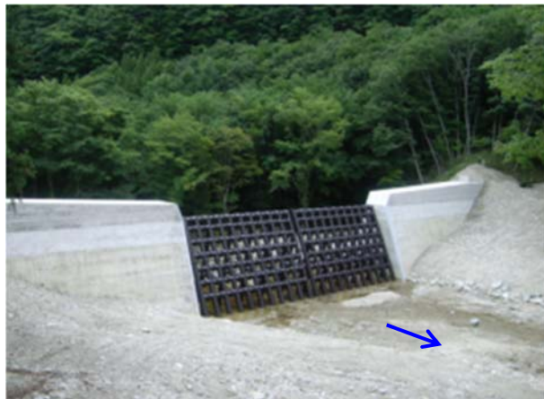
砂防堰堤完成イメージ
