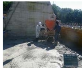
従来工法 (コンクリート打設)
