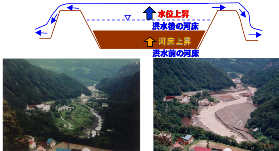
洪水前(左)・後(右)における河床上昇の事例(姫川水系河川整備基本方針より抜粋)
