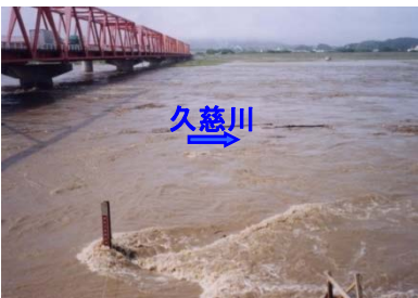
久慈大橋(東海村豊岡地先) 付近の出水状況
