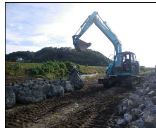
袋詰め根固制作状況
