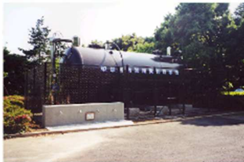
飲料用貯水槽 約15万ℓ分の飲料水を確保することが可能
