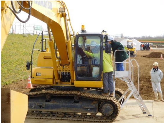
マシンコントロール（MC）バックホウ操作体験の様子
