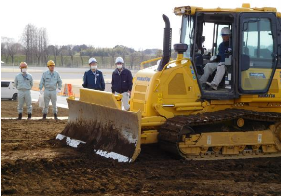
マシンコントロール（MC）ブルドーザ操作体験の様子
