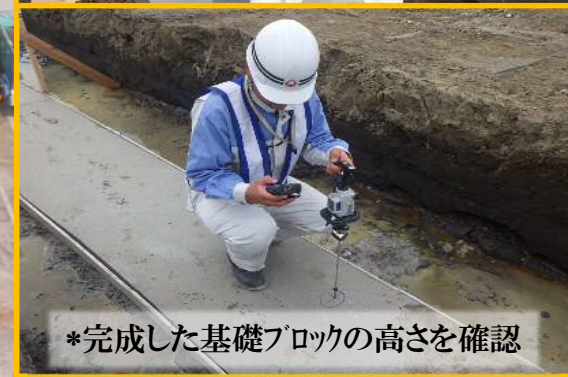
*ブロック積みの施工前の正確な位置出し
