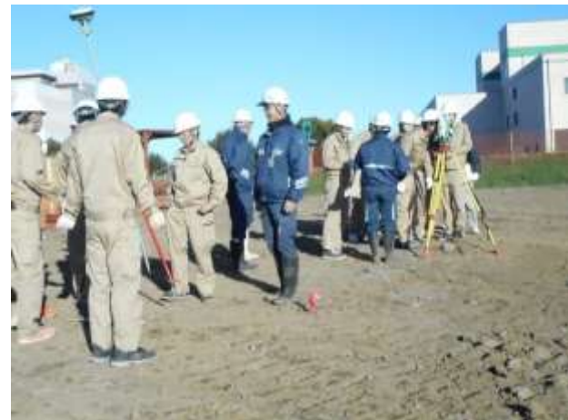
■ 自動追尾型TS、GNSSローバー操作体験
