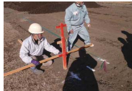
丁張り・貫板設置
