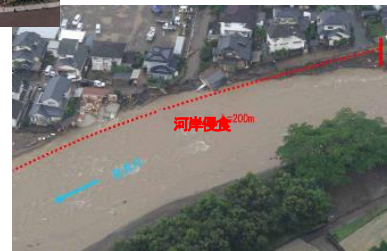
河岸侵食に伴う家屋倒壊等
