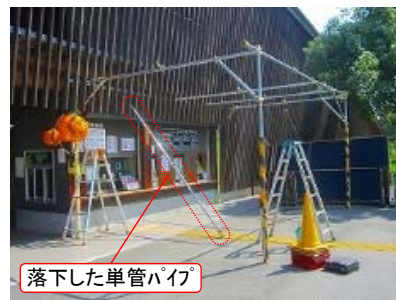
設置状況(事故直後)
