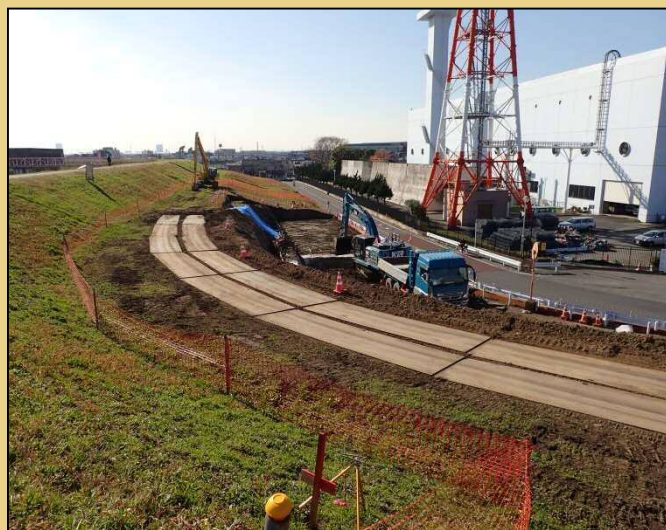
(川裏側) 堤防法尻部分に排水対策工を設置しています。
