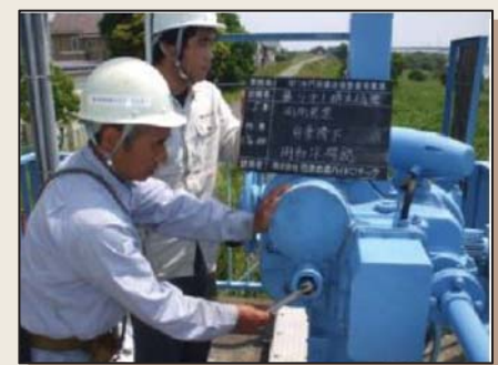
▲河川管理施設の点検状況
