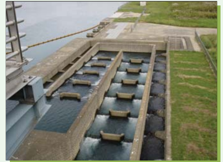
▲相模大堰の魚道
