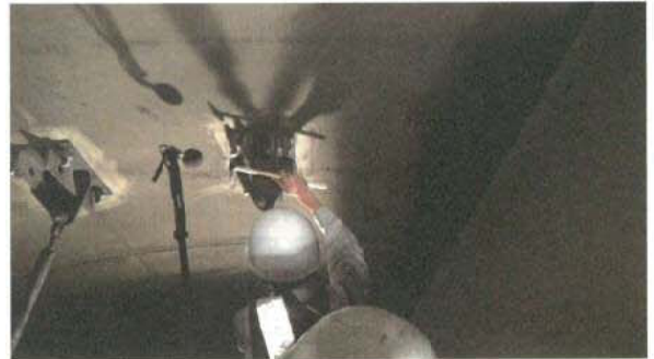
写-3 ジェットファンの打音収録状況
