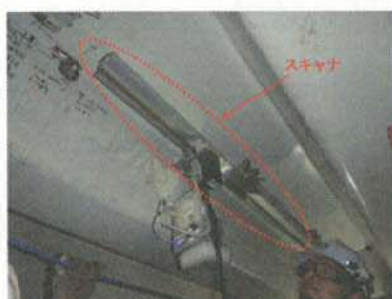
写-6 非破壊検査技術を用いた鋼床版疲労き裂の自動探傷の状況
