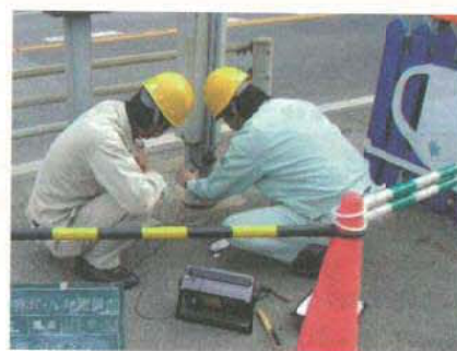
写-5 損傷調査の状況
