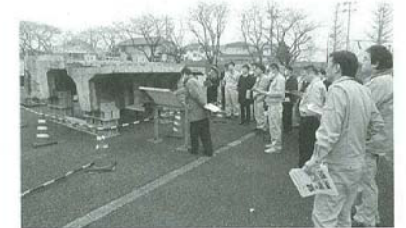
写真—9 50年経過した橋脚劣化サンプル
