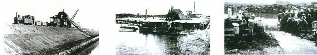
わたらせがわ ゆうすいちか こうじ しょうす 渡良瀬川・遊水地化の工事の様子
