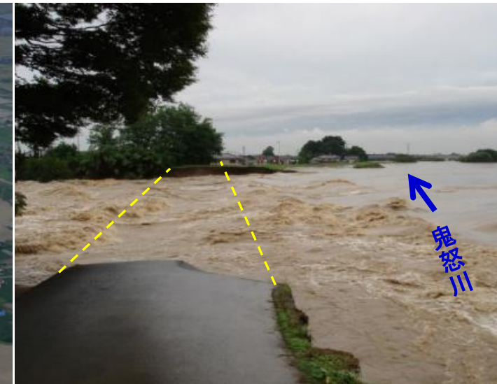
被災状況(拡大写真)
