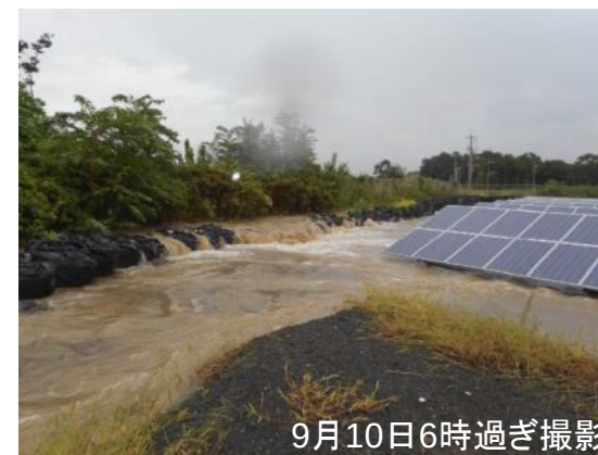
①溢水箇所(25.35k付近)溢水状況
