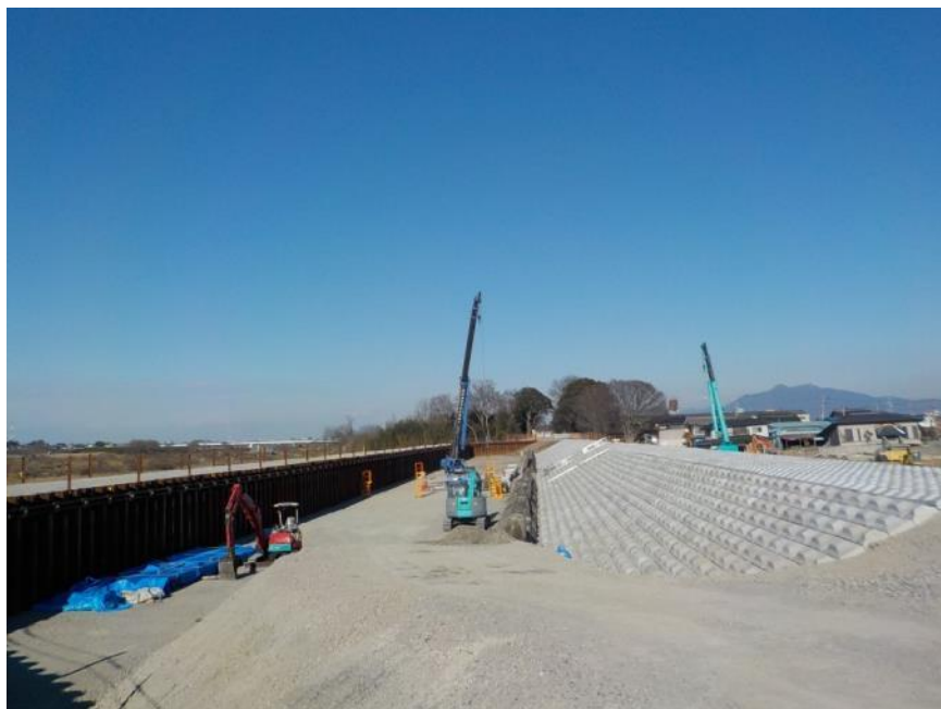
H28.1.14 荒締切の撤去に着手
