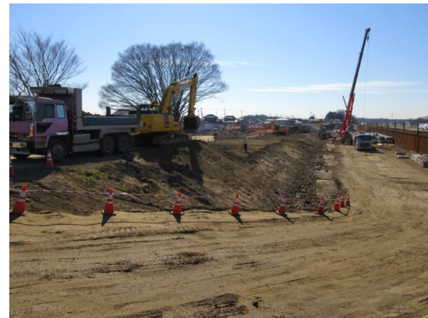
H28.1.27 仮堤防(盛土)掘削中
