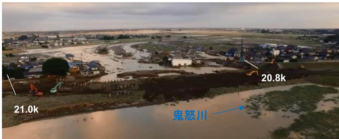
応急復旧状況(9/12)
