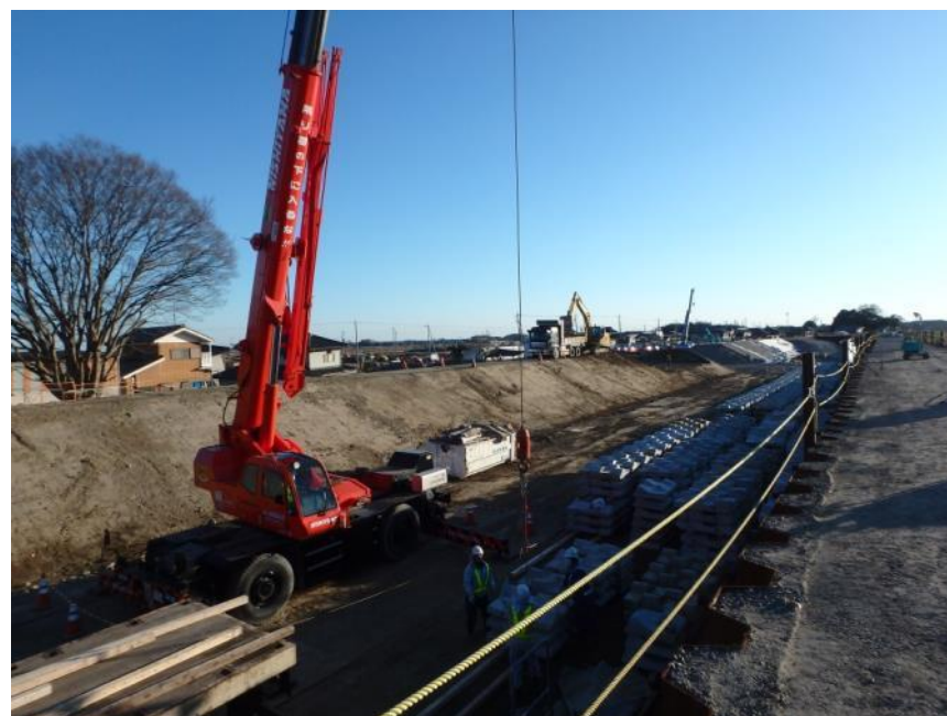
H28.1.25 仮堤防(盛土)掘削開始
