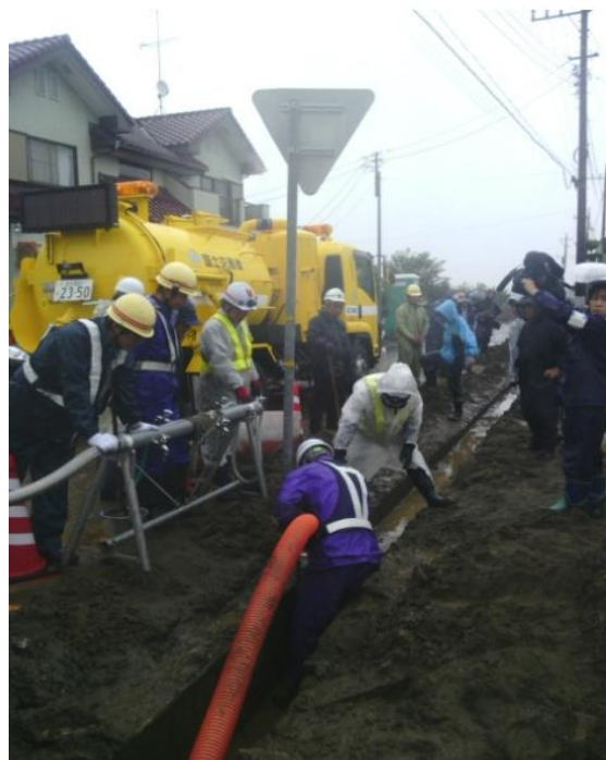
側溝清掃車による堆積土の撤去
