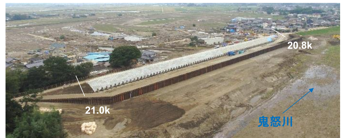
応急復旧状況(9/24)
