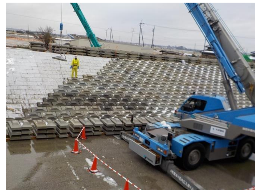
H28.1.18 接続ブロック撤去
