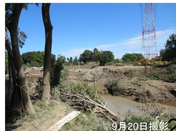
⑤溢水箇所(24.75k付近)排水後
