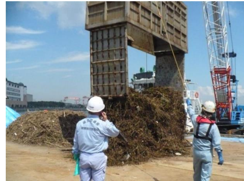
漂流物の陸揚状況
