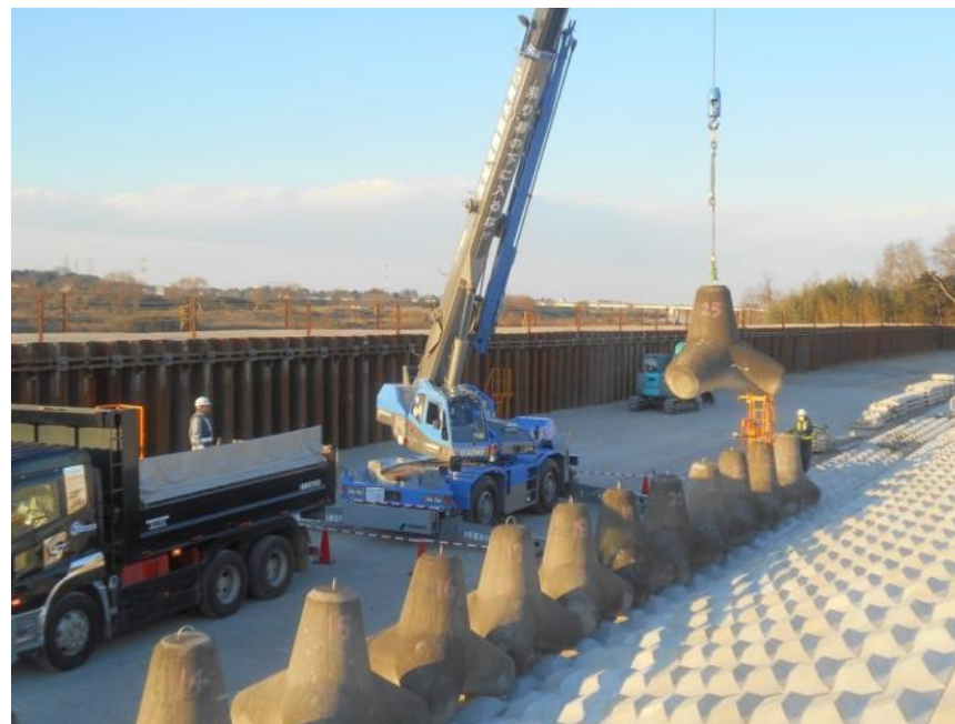
H28.1.14 根固めブロック撤去
