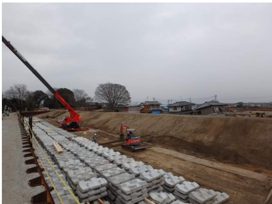
H28.1.23 接続ブロック撤去完了
