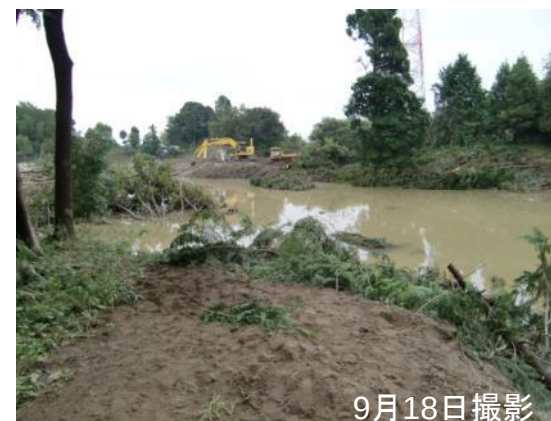
⑤溢水箇所(24.75k付近)排水前
