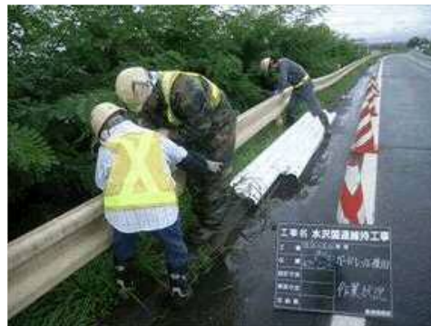
＜防護柵の取替＞
