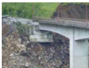
斜面変状による橋台の沈下
