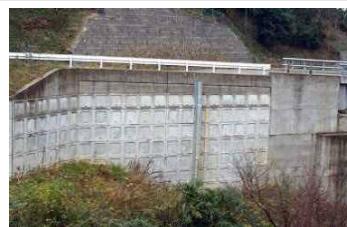
盛土(補強土壁)
