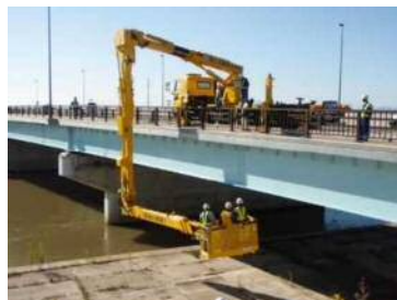
橋梁点検車による点検
