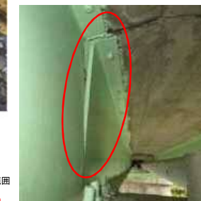
主桁の変形
