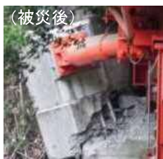
制震ダンパー取付部の損傷
