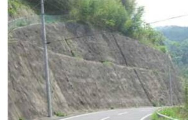
モルタル吹付
