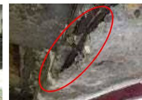
鉄筋の露出
