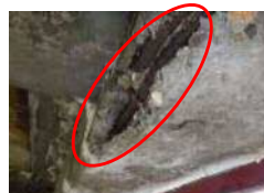
鉄筋の露出
