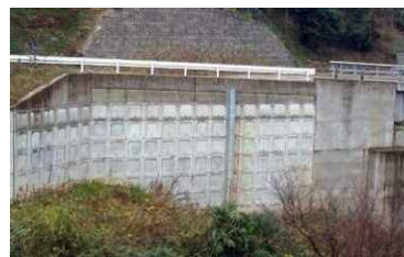
盛土（補強土壁）
