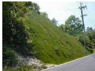
切土(法面保護)
