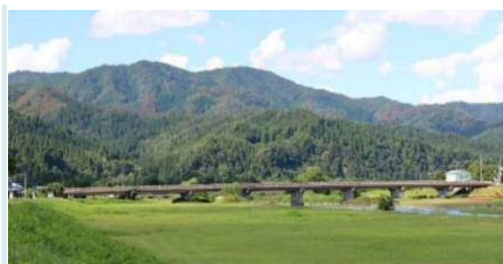
<万石橋の状況>
