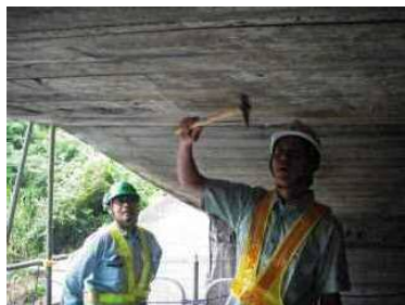
目視及びハンマーによる打音検査
