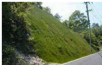
切土（のり面保護）
