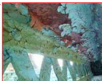
鋼材の腐食
