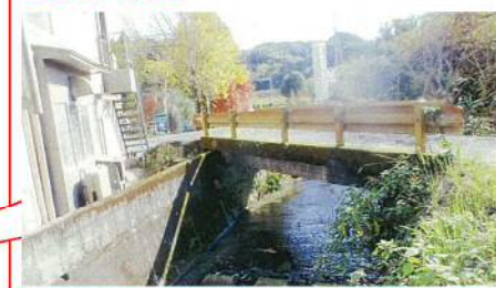
老朽橋の撤去
