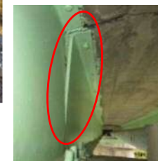
主桁の変形
