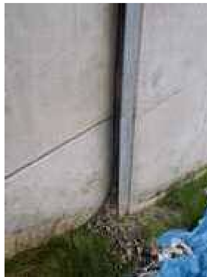
写真 土砂のこぼれ出し例
