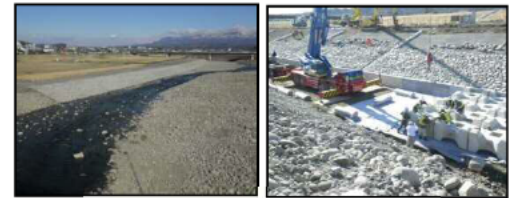
三吉町下流災害復旧工事
