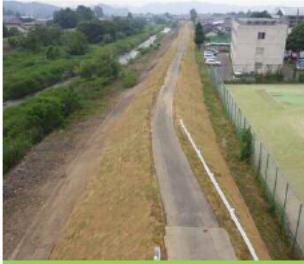
工事完成状況（中里橋下流）
