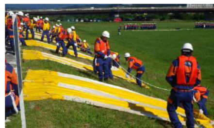
水防工法（シート張り）
