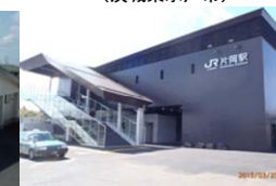
⑥ 片岡駅東西自由通路 (矢板市)
