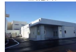
⑨ 古山小学校 (下野市)
