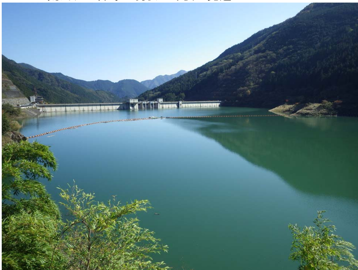
滝沢ダム(平成29年10月26日撮影)
