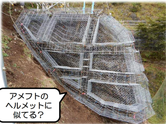
【10月11日撮影】 山腹基礎端部の補修状況。 これからモルタルを吹き付けます。
