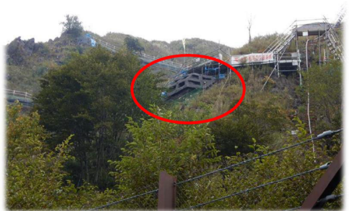
【10月11日撮影】 モルタル吹付が完了した箇所です。 周りの岩と色を合わせるため、着色しています。
