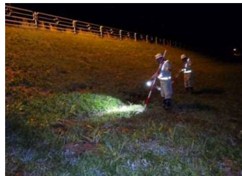
川裏の状況 確認中 (佐原出張所管内 10/24 0:00)
