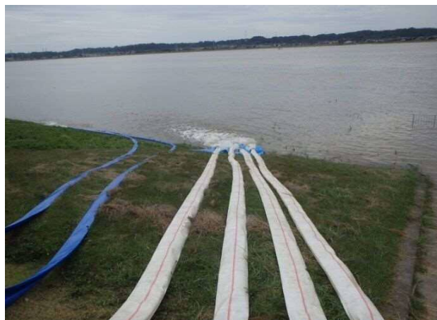
国土交通省排水ポンプ車による内水排除 (利根川に排水)
