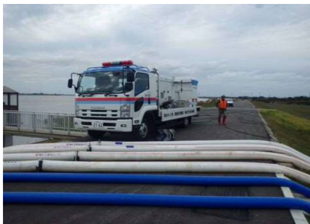
国土交通省排水ポンプ車による内水排除
