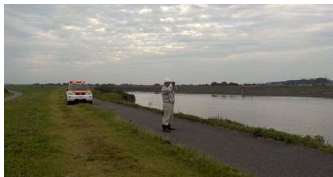
河川巡視 (取手出張所管内 10/24 15:30)
