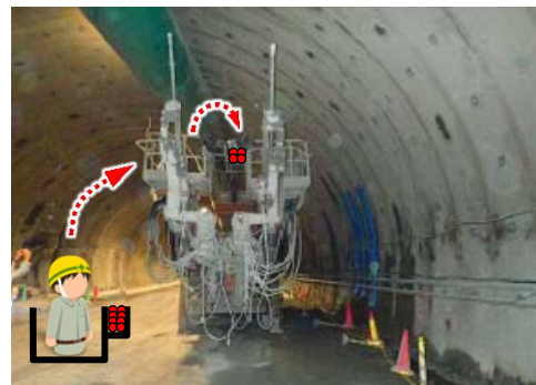
片側に全て積載し、マンゲージを上げたのち、もう一方のマンゲージへ積み替え
