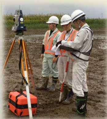
学校でも学んでいる知識？ 湿地再生箇所の掘削出来形測量
