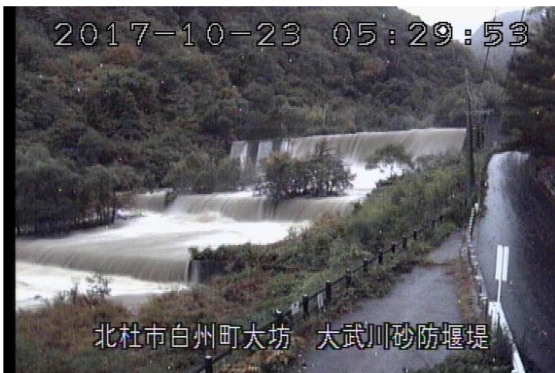
大武川砂防堰堤（北杜町）（10月23日 5時30分頃）
