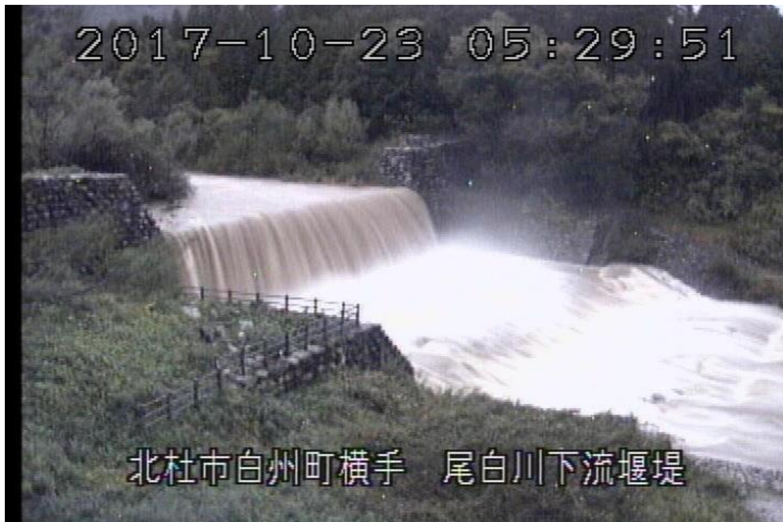
尾白川下流砂防堰堤（北杜町）（10月23日 5時30分頃）
