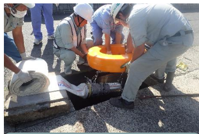
平成29年9月4日草加市合同 設置訓練 (草加市稲荷町)
