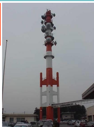
【写真2】 江戸川河川事務所の通信用鉄塔
