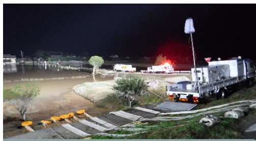
平成27年9月鬼怒川での稼働状況 (他事務所での活動)
