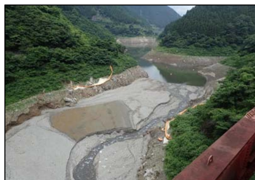
浦山大橋下流 (H29. 7. 28)
