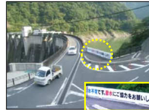
荒川二瀬ダム天端
