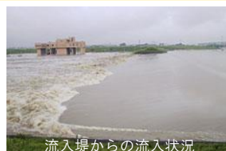
流入堤からの流入状況
